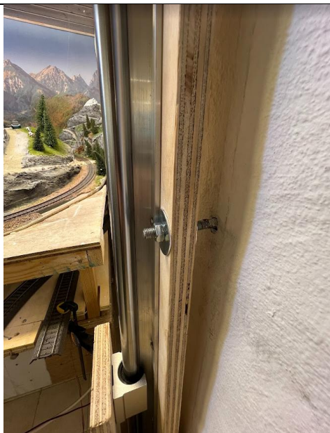
8 stk. M8 gevinstænger pr skinne blev monteret – de blev fastgjort med Fischer injektionsmørtel
