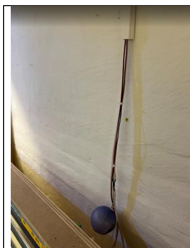
Eksterne forbindelser til vitrine – forsøg med kontravægt bold – plastbold fyldt med møtrikker 😊
