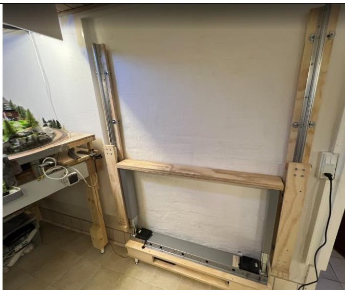
Klar til montage af vitrinen. Hævesænke benene bruges nu til at løfte vitrinen – de er IKKE længere fastgjort til vitrinen.
