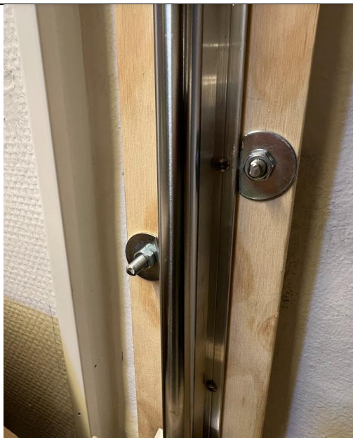
Der blev fræset vandrette huller i den 20 mm krydsfinerplade, så den kan justeres både ind og ud samt til siderne.
